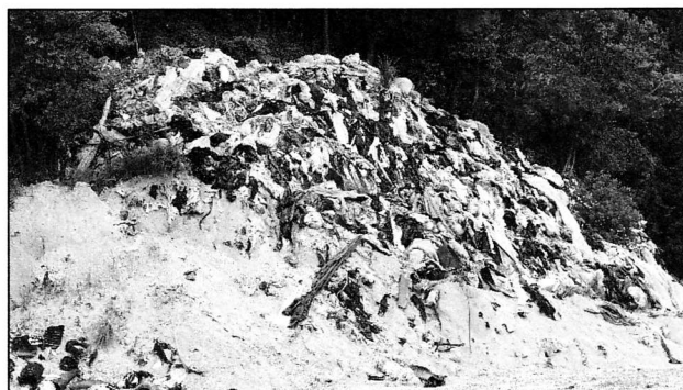
2020.9.3撮影 埋立終了区 覆土されてない 環瀬戸内海会議幹事・岡田和樹さん提供
