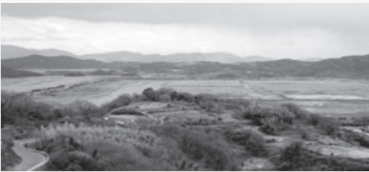
締め切り堤防(左)の内側に広がる錦海塩田跡地。流入する雨水や生活排水をポンプで排出しないと周囲の民家や農地、工場が浸水する恐れがある 2009. 4. 2付け 山陽新聞
