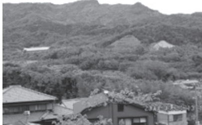
寒霞溪への登り道、剥ぎ取られた山肌が痛々しい 09.4.24
