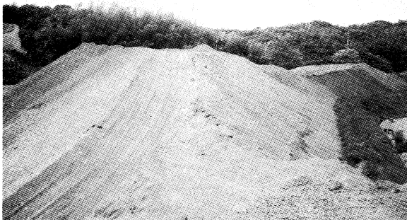
07.4.27 野積みされた鉄鋼スラグ（西湊町榎田地区）
