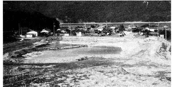
06年9月 吉海町鉄鋼スラグ「一時保管場所」中央部の「池」に強アルカリ化した雨水がたまっている
