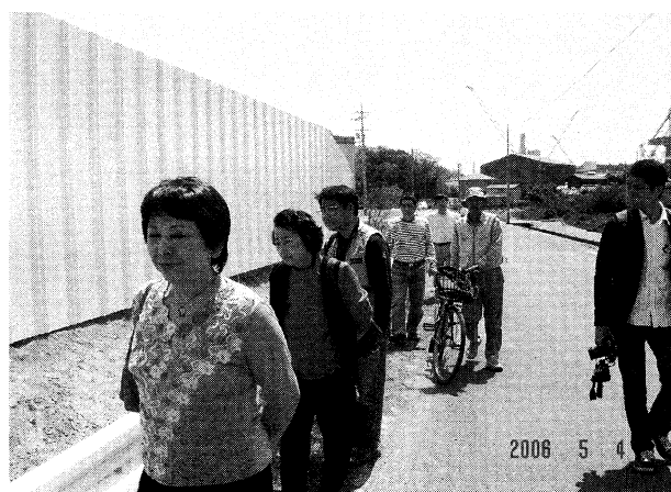
06.5.4 スラグを囲うフェンス(高さ3m)
