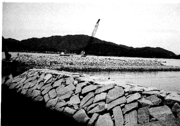
自然石を使って、離岸堤の工事中
